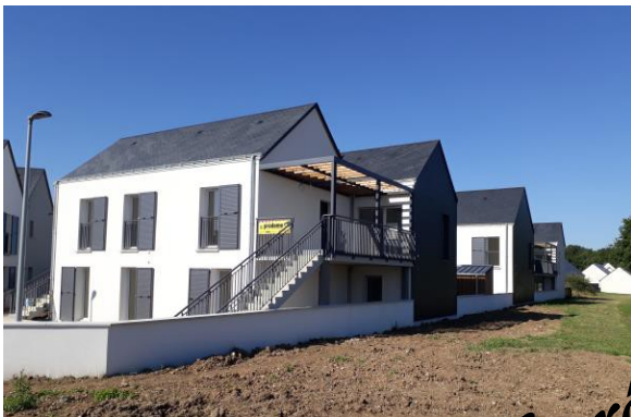
Exemple d'habitat semi-collectif (Montbazou - 37)
