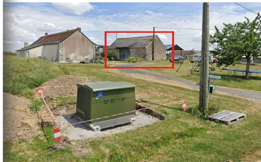
Photos du bâtiment
