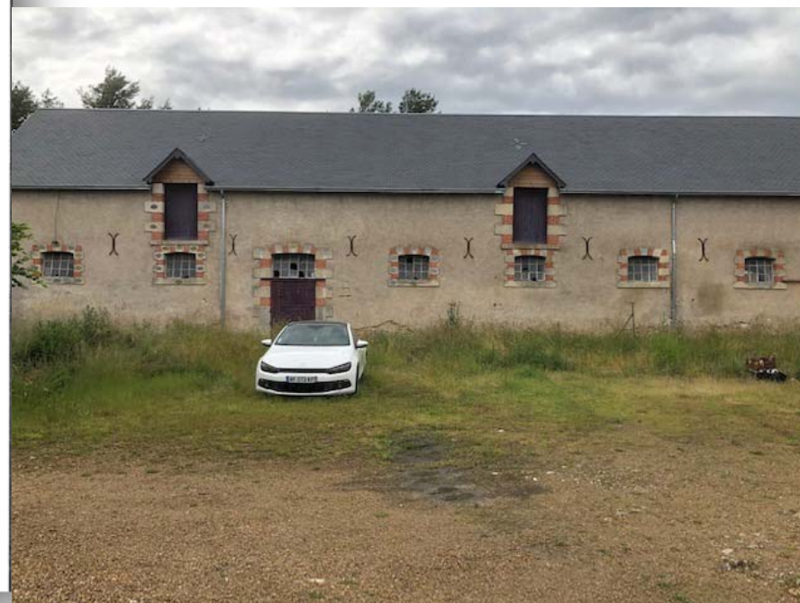
Photos du bâtiment
