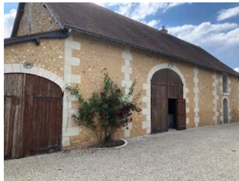
Photos du bâtiment en arrière plan
