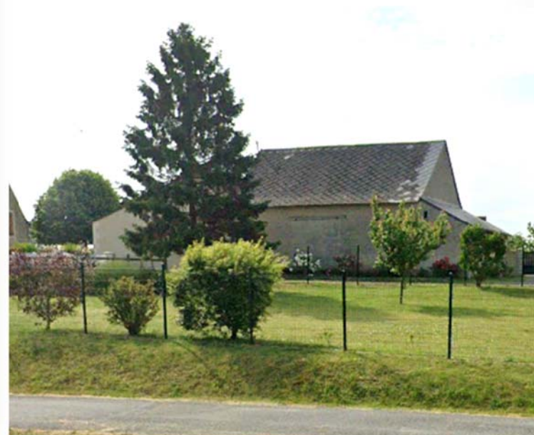
Photos du bâtiment
