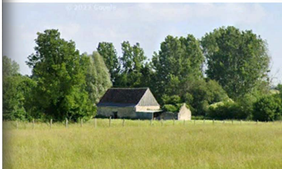
Photos du bâtiment
